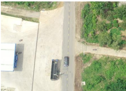
Đường thảm nhựa Bàu Cạn bề rộng đường 6m và đường bê tông 3m
