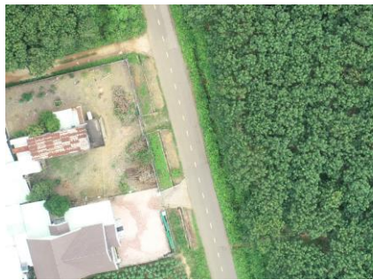
Đường thảm nhựa mặt đường 6m, khu vực suối 1 đi suối 2, ấp 4 xã Tân Hiệp.
